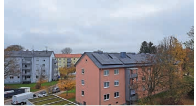
PV-Module für den Bürgersolarpark wurden u. a. auf einem Mehrfamilienhaus im Kalker Feld montiert. Foto: KIMM e. V.
