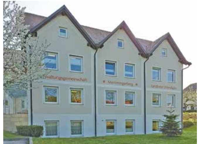
Die Gemeinde Memmingerberg plant die Versorgung mit Nahwärme im Ortskern. Foto: Svenja Gropper
