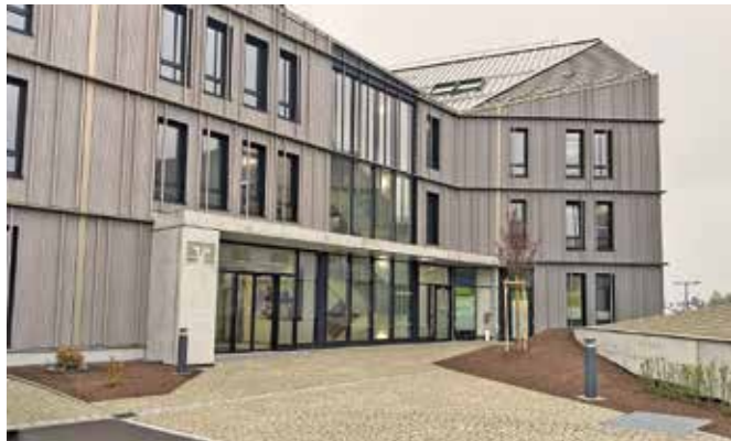
Ins erste Gebäude auf dem neuen Campus an der Ortstaste Memmingerberg ist die VR-Bank eingezogen.
