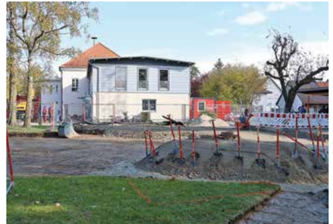
Der Erweiterungsbau des Kindergartens Steinheim wird an die Südwestseite des bestehenden Gebäudes angebaut. Die Arbeiten sind bereits im vollen Gange.
