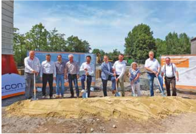
Beim symbolischen Spatenstich am zukünftigen Heizwerk Memmingen Süd/Benningen, von links: Andras Müller, Enrico Lagoda (Projektleiter e-con AG), Martin Wechsel (Zweiter Bürgermeister von Benningen), Jürgen Steigmüller (ehem. Geschäftsführer Rohde & Schwarz), Maximilian Steigmüller (Leiter Infrastruktur Rohde & Schwarz), Julian Schempp (Finanzvorstand e-con AG), Peter Waizenegger, Margareta Böckh, Martin Osterrieder, Christian Seeberger (stellvertretender Landrat Unterallgäu).
