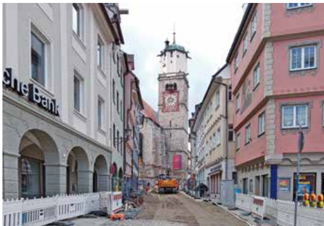
Der Ausbau der Zangmeisterstraße hat mit der Erneuerung des Abwasserkanals zwischen Marktplatz und Westertor begonnen. Foto: Svenja Gropper
